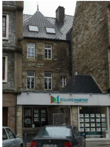
Place du Général Leclerc : Ancien Hôtel particulier dit Hôtel de Kersauzon. Le portail, visible sur les cartes postales anciennes a disparu (seul reste un pilier)
