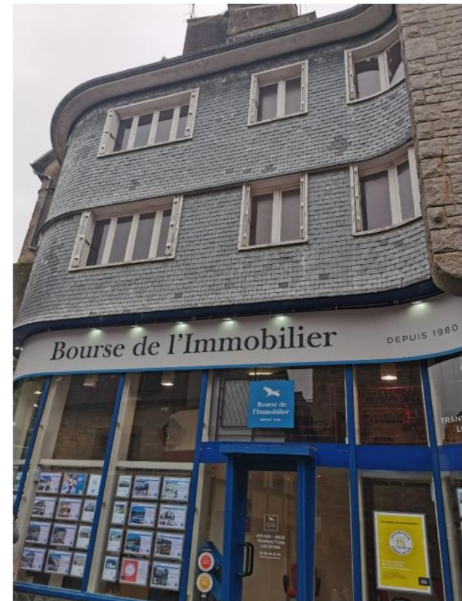
9-11 rue Duguesclin, Roger Le Flanchec Une intégration qui évite, par le mouvement de façade et les ardoises, un aplat trop impactant.
