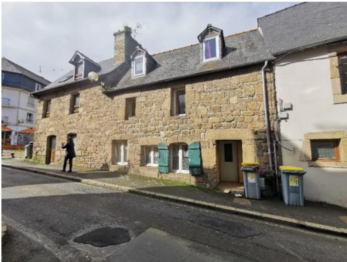
22 et 24 rue de Kérampont
