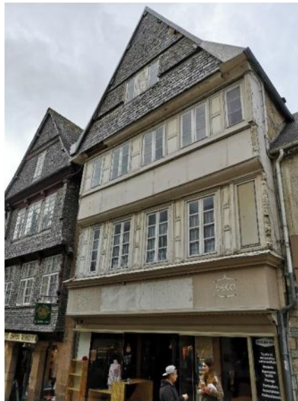
5 rue Emile Le Taillandier
