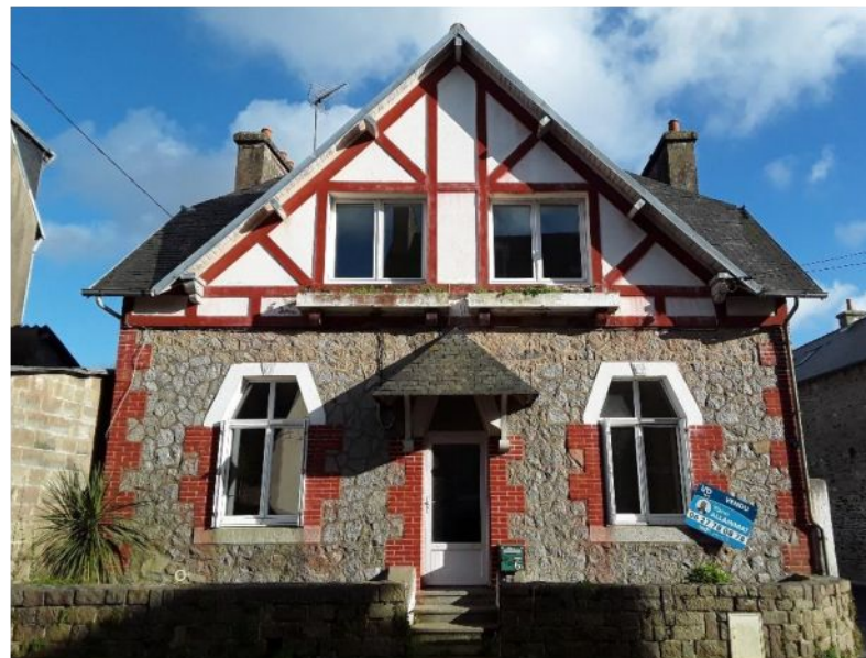
Maison type Loi Loucheur, 6 Rue des Haras
