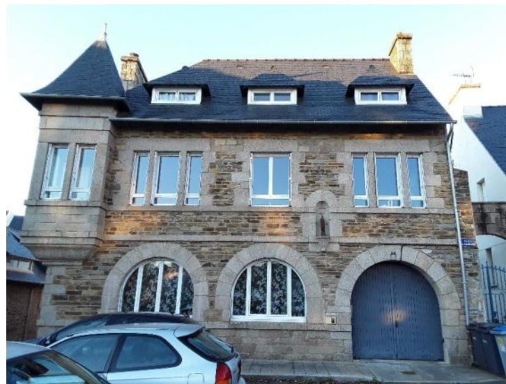
Maison d'architecte de James Bouillé, 7 Place du Marchallac'h
